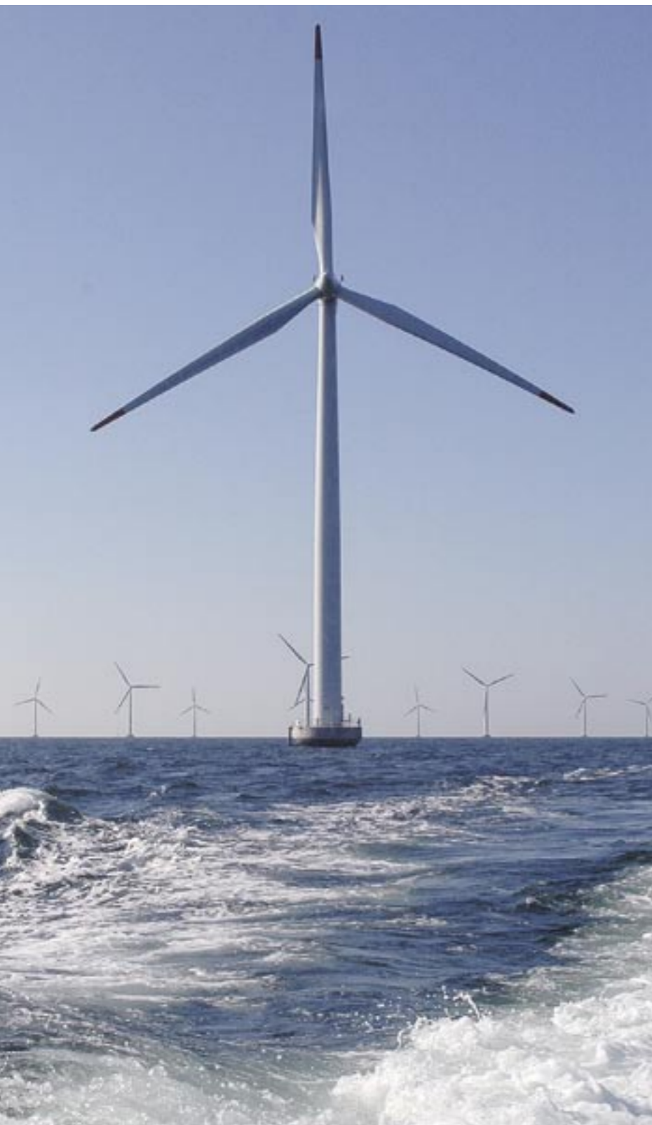
Offshore Windpark Nystedt in Dänemark mit 72 Siemens 2,3 MW-Windturbinen
